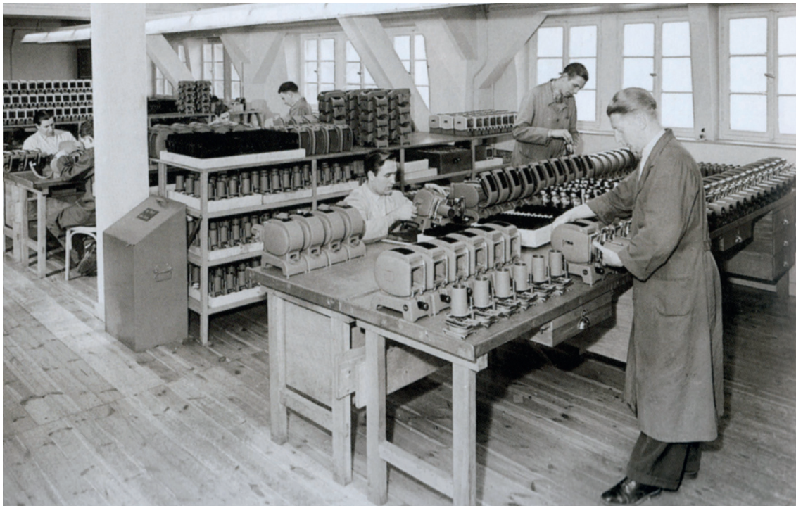
Endmontage der Kleinbildprojektoren im Dachgeschoß des Hausertor-Werkes
