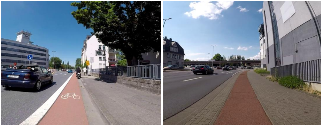
Abbildung 16: Nicht benutzungspflichtige Infrastruktur an der Schützenstraße/ Friedrich-Ebert-Platz (links) und der Gloelstraße (rechts)
