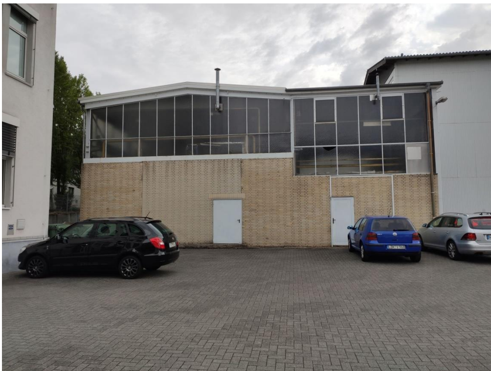
Foto 6: Abzubrechendes Gebäude (IV) von Südwesten
