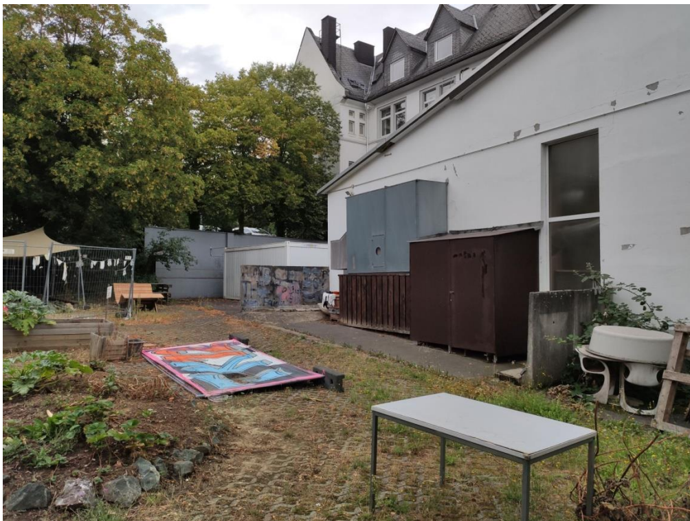
Foto 8: Abzubrechendes Gebäude (II) von Westen
