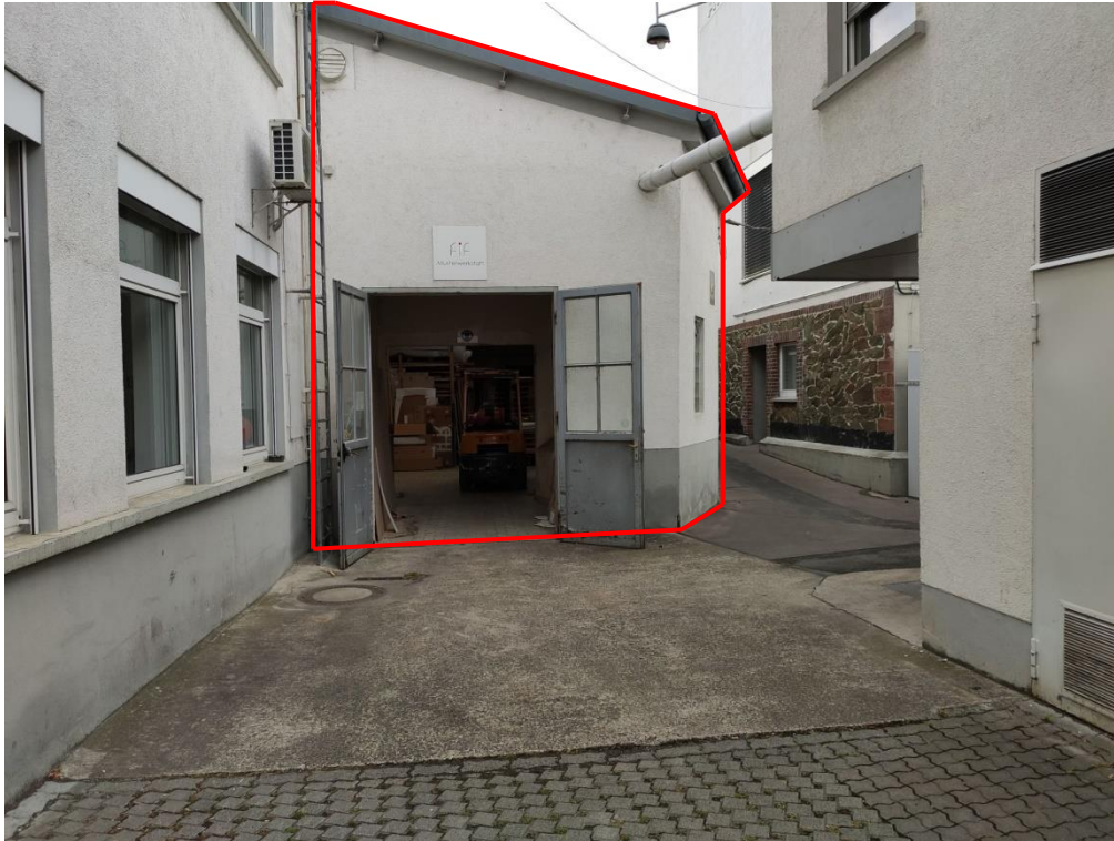
Foto 7: Abzubrechendes Gebäude (II) von Südosten
