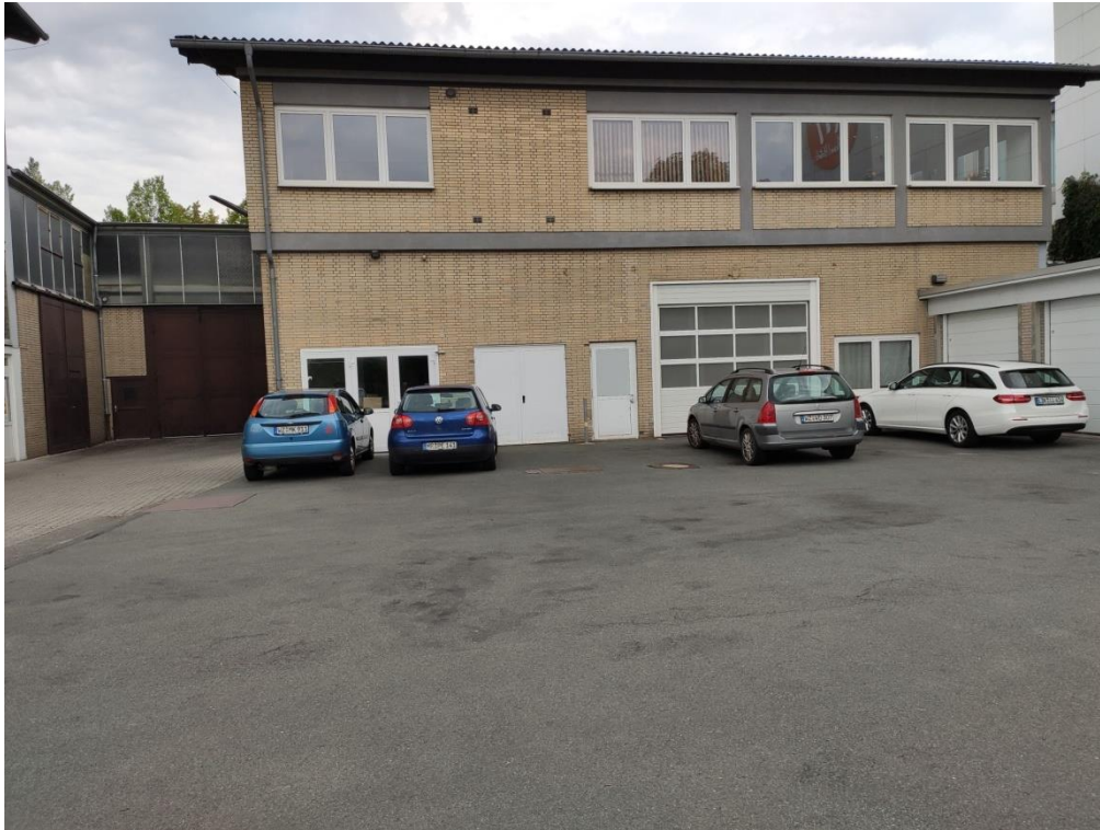
Foto 3: Abzubrechende Gebäude (IV) von Südosten
