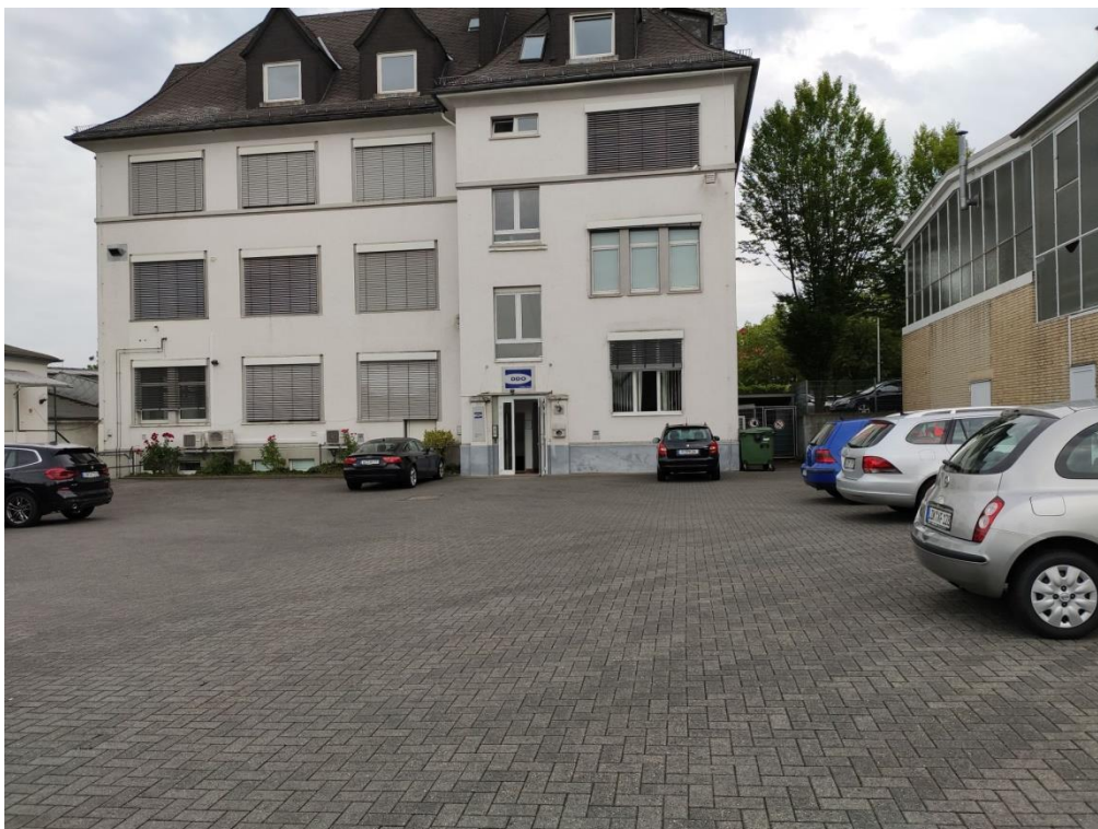
Foto 2: Ansicht des „P-Baus“ von Südosten
