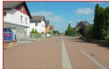
Beispiel: Trennung von Fahrbahn und Gehweg mittels Bord-/Rinnenanlage
