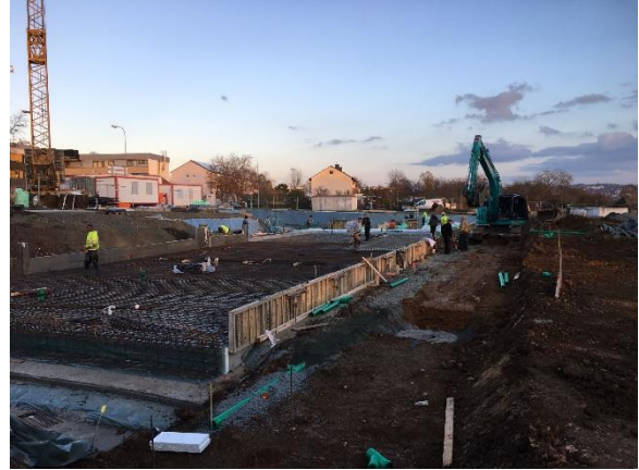
Bodenplatte Untergeschoss
