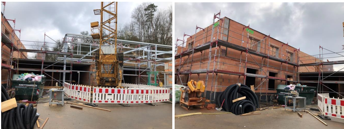
Bild: Interimslösung Ludwig-Erk-Straße im Bau (Stand 03/2022)
