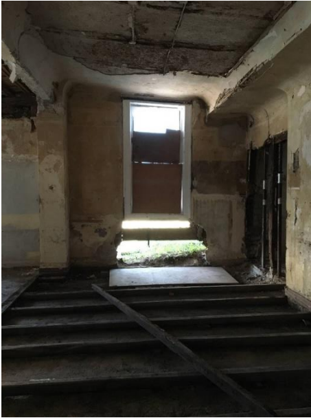
Spielbereich nach Abbruch des Bodens
