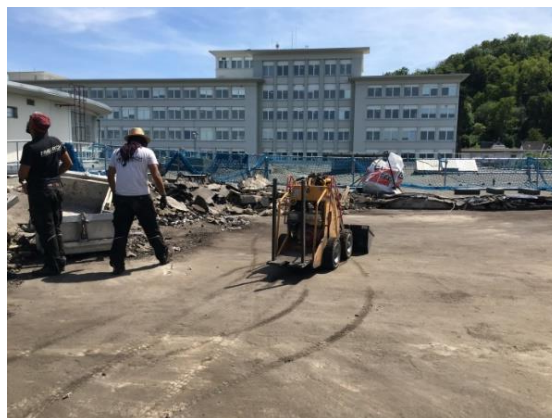
Abriss vorhandener Dachaufbau
