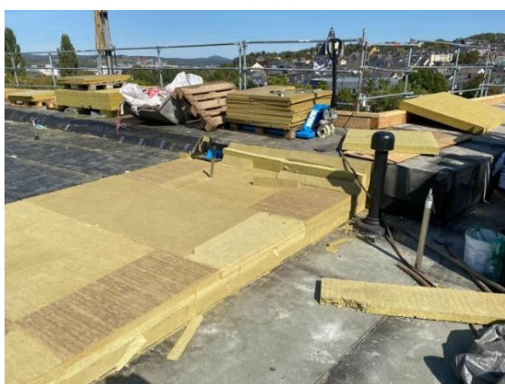
Neue Dachdämmung
