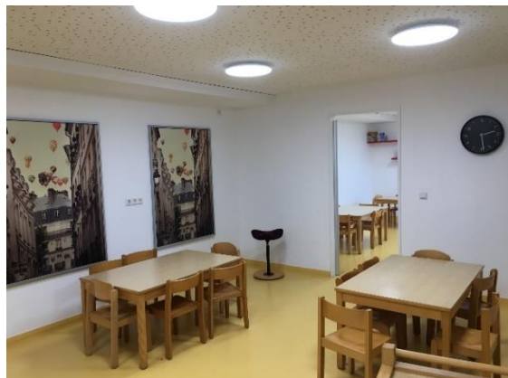
neuer Bodenbelag und Akustikdecke
