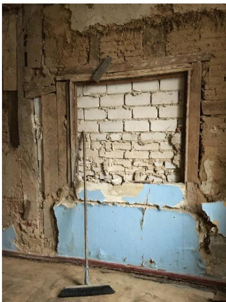
Vorh. Konstruktion im EG nach Freilegung
