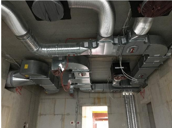
Rohinstallation Lüftung
