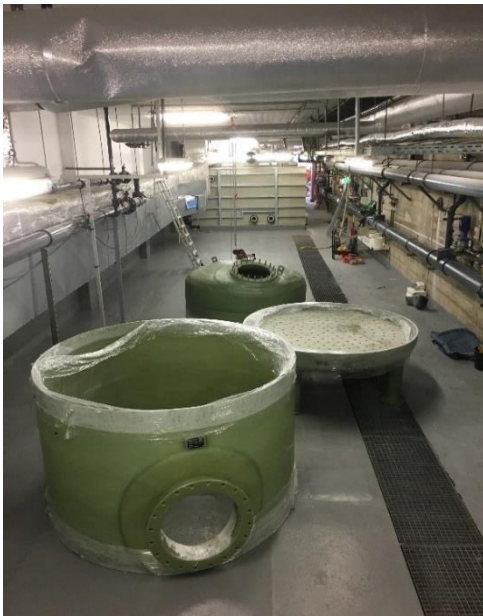
Einbringung der neuen Sandfilter
