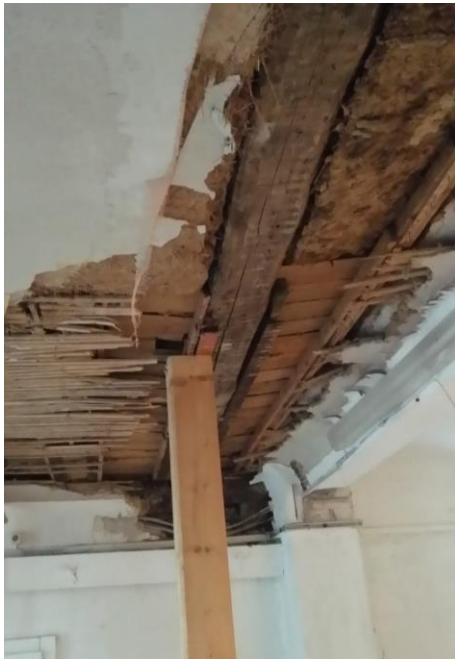
Deckenkonstruktion im EG nach Freilegung
