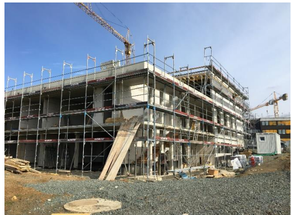
Rohbau mit Gerüst
