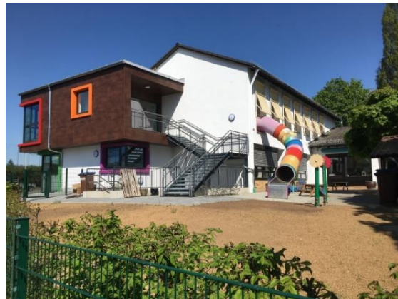
Hofansicht mit neuer Fluchttreppe
