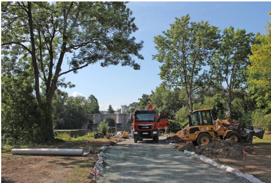
Während der Bauarbeiten im August 2020
