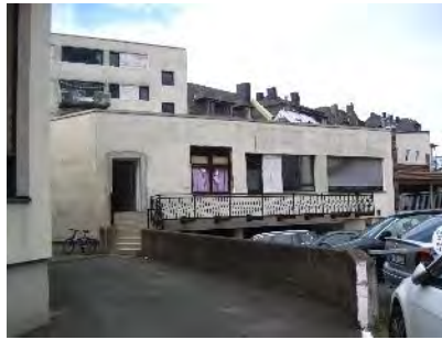
Gebäudeansicht aus Richtung Lahn
