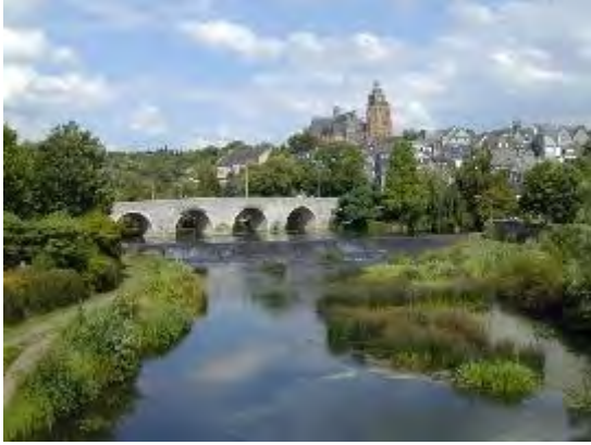
Abbildung 13: Blick zur alten Lahnbrücke
