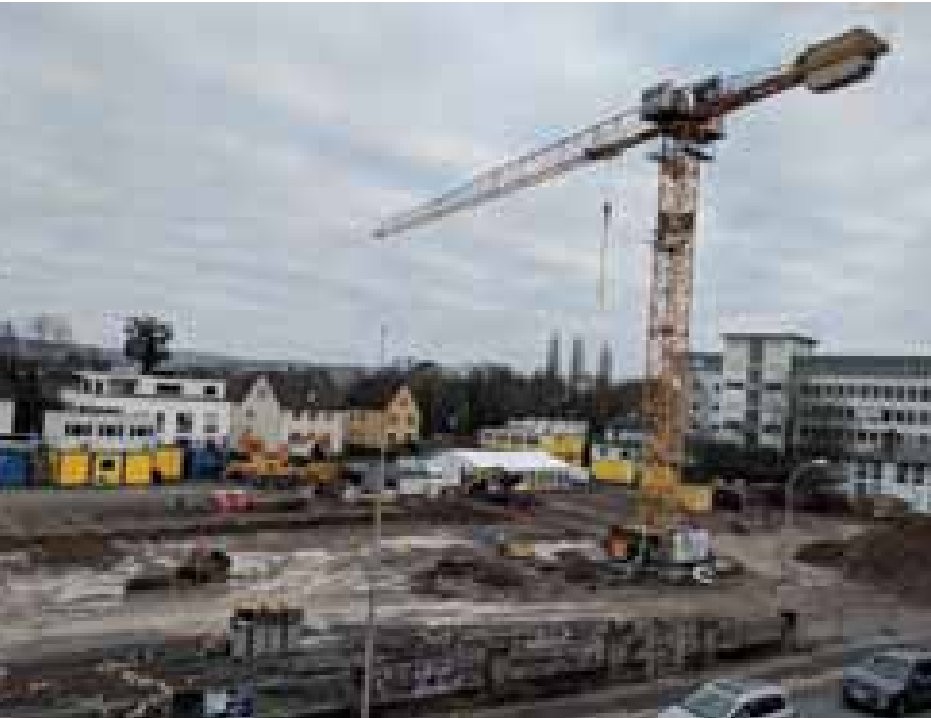
Die Baustelle der Feuerwache I am 15. Dezember 2023
