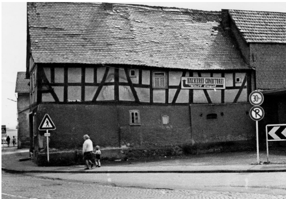
Das alte Haus des Herrn Karl Engel vor dem Abbruch. Blick auf die Längsseite von Wetzlar kommend.
